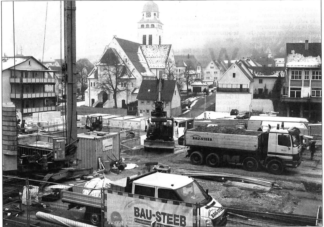
Baustelle im Herzen Tailfingens: Die Technologiewerkstatt soll dem Wirtschaftsleben Albstadts neue Impulse geben.
